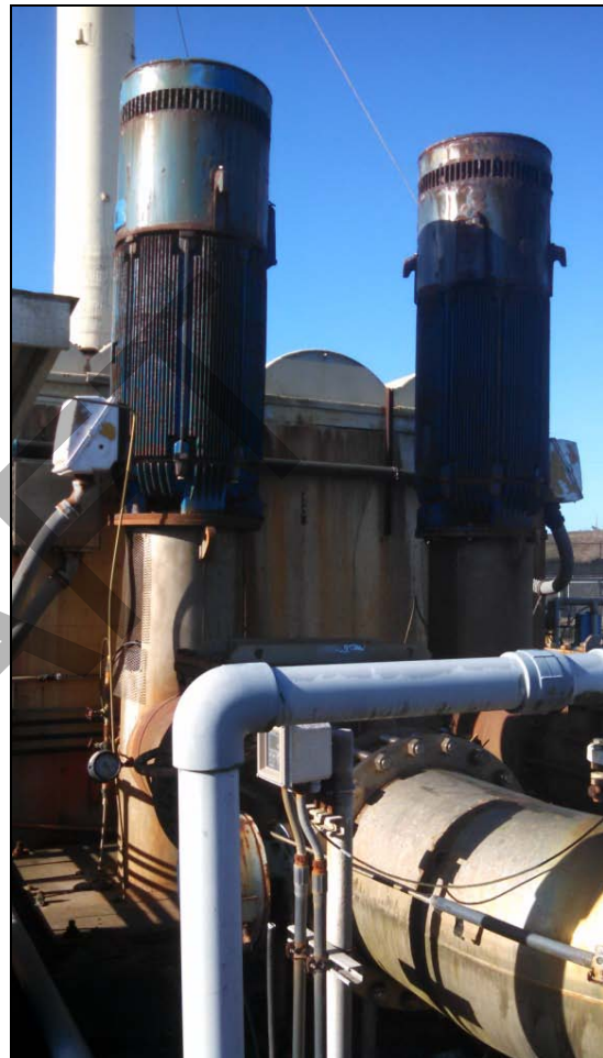
Photo 2: Effluent Pumps
