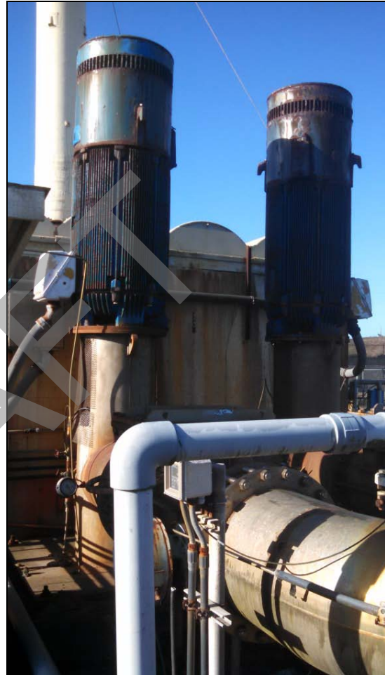
Photo 2: Effluent Pumps
